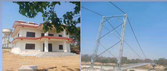
वडा नं १ वडा कार्यलय भवन निर्माण र रामघाट झुलुंगे पुल निर्माण सम्पन्न
