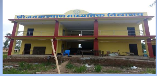
४ कोठे भवन निर्माण
